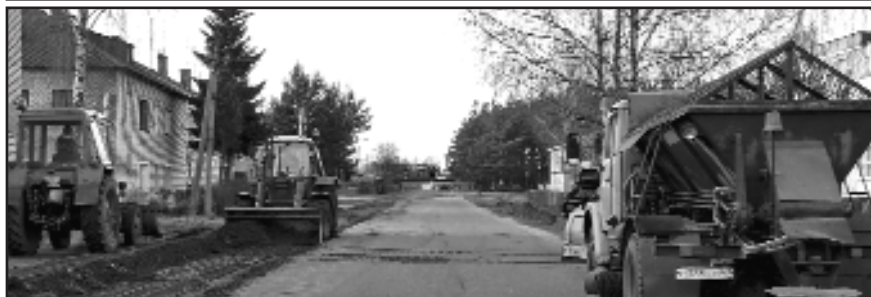
Будни коммунальной службы Фото В.С.Воробьева 04.12.09г.
